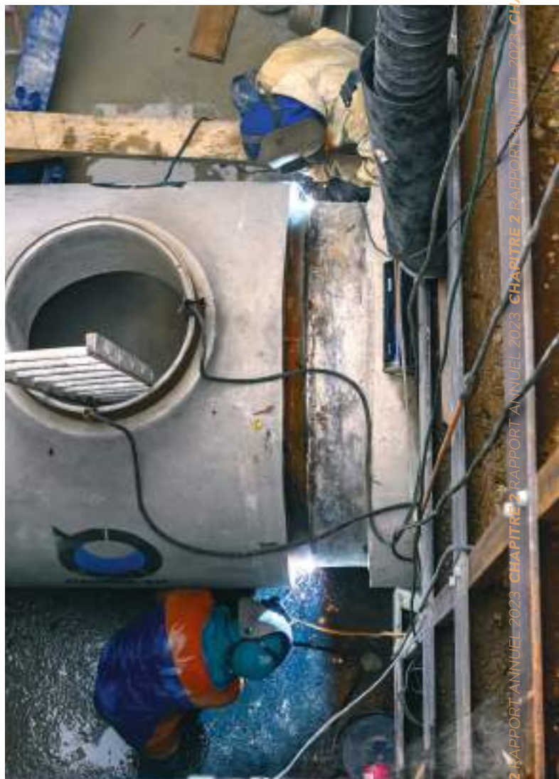
Renouvellement d'une conduite de transport à Saint-Maur-des-Fossés
