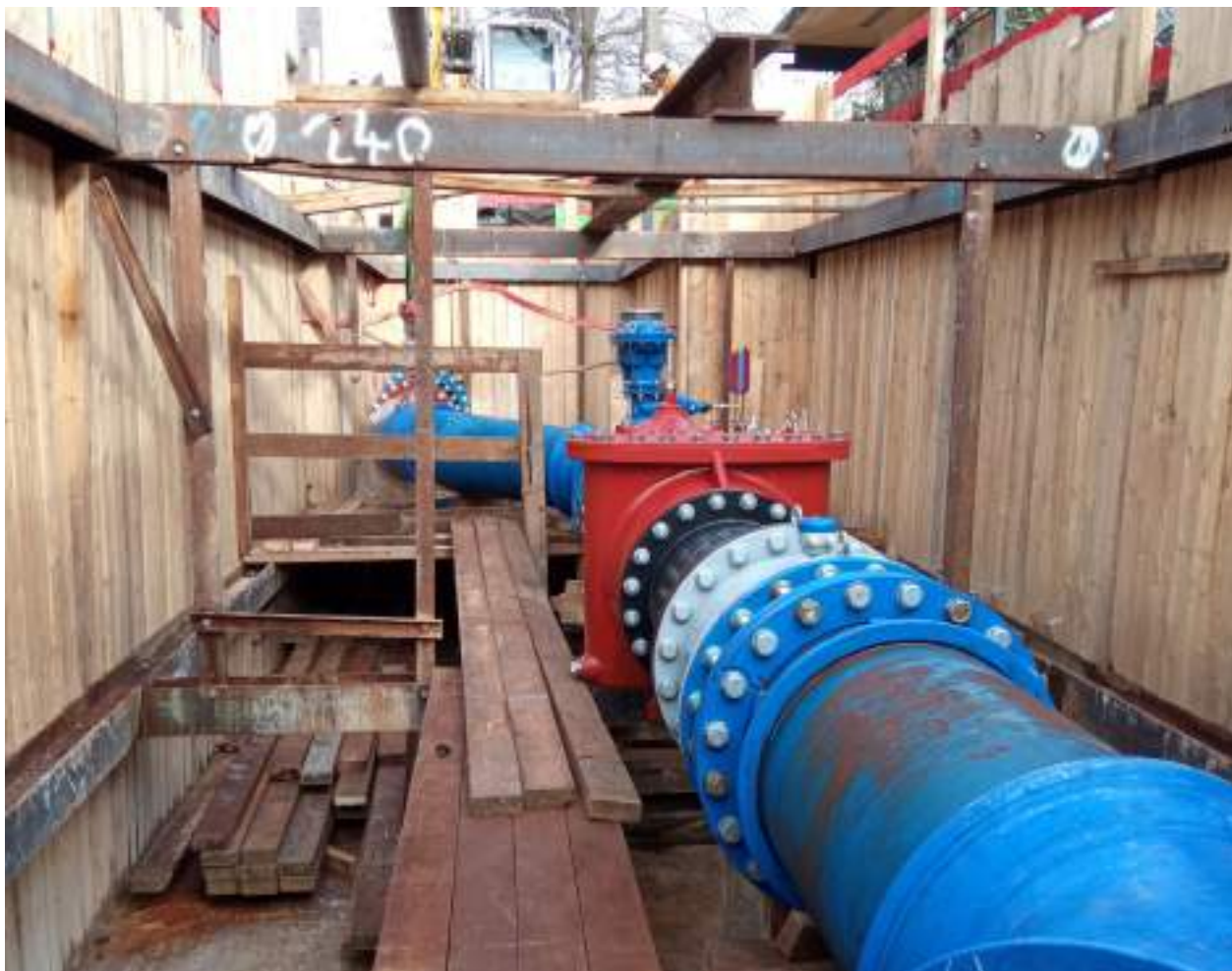
Chantier de sectorisation à Saint-Denis
