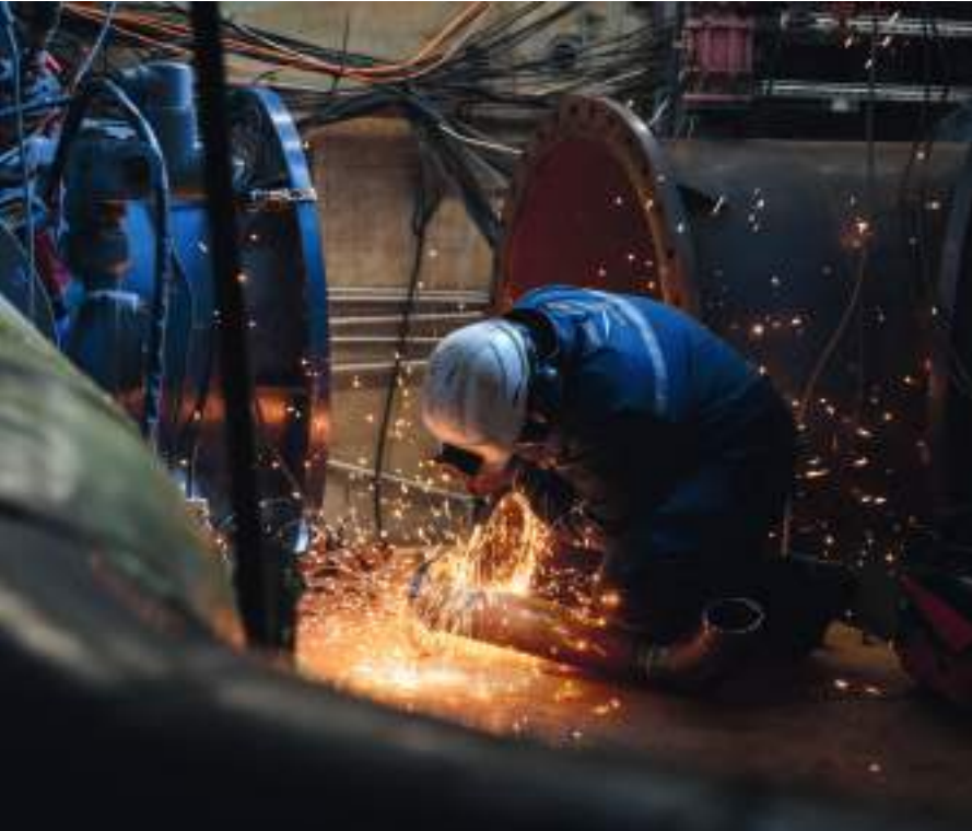
Chantier de renouvellement des équipements à Villetaneuse
