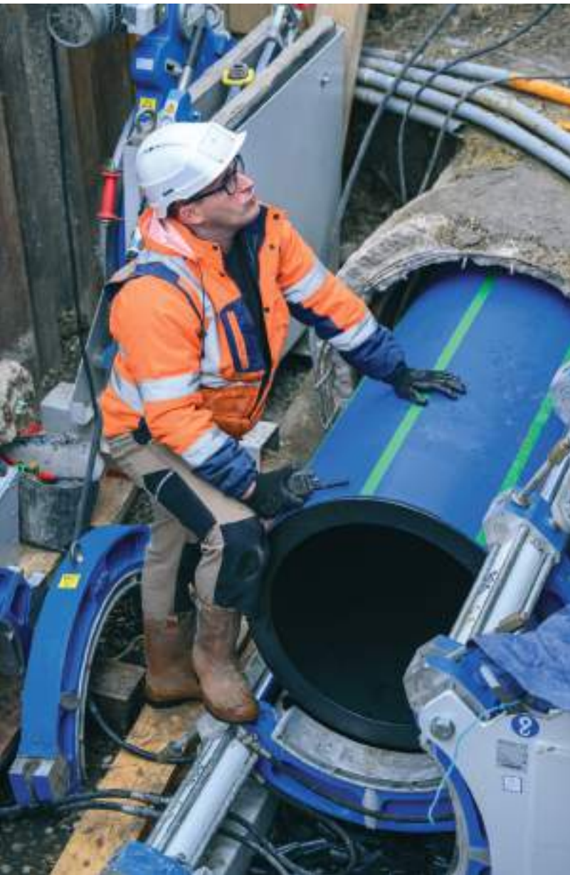
Renouvellement d'un feeder à Saint-Denis
