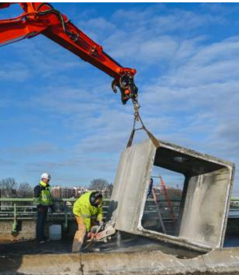
Chantier de pose de canalisations sur le Pont de Saint-Denis
