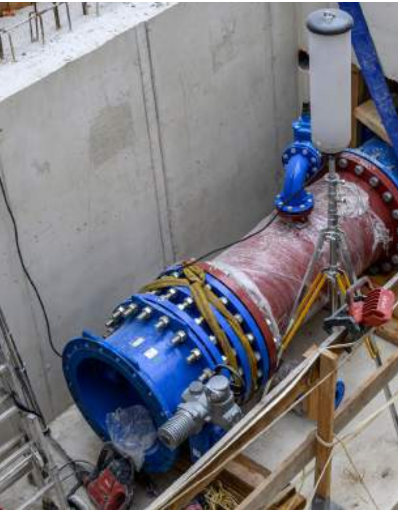
Chantier de raccordement à Saint-Maur-des-Fossés
