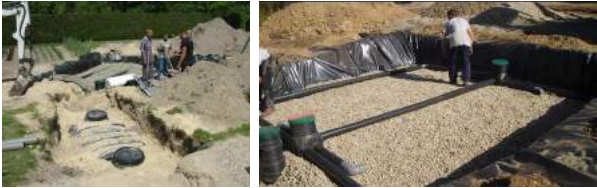
Photos: Situation de l'installation d'assainissement non collectif avant le contrôle de bonne réalisation.
